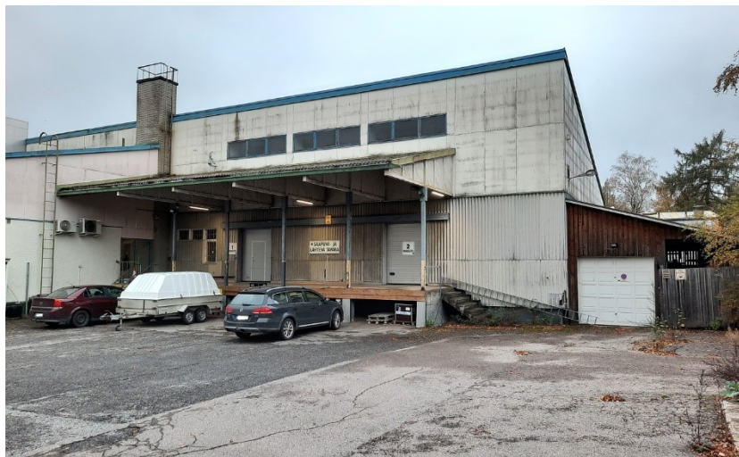
Kuva 14: Asemakaava-alueen nykyinen rakennus ja lastauslaituri pihan puolelta.
