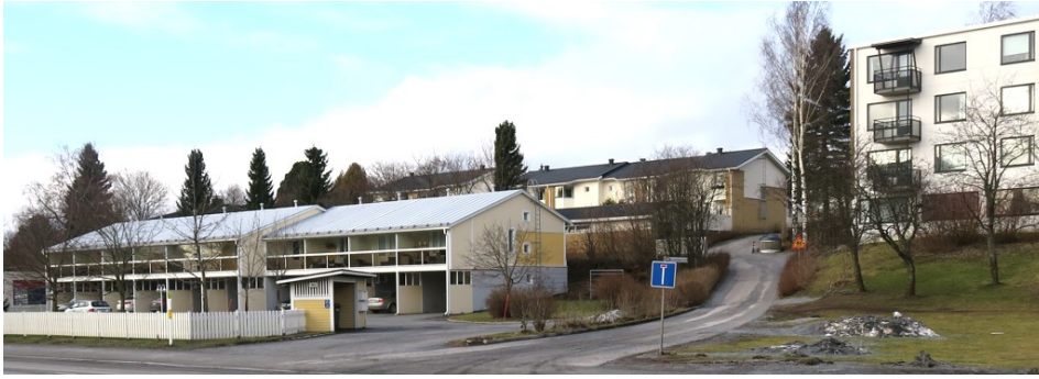
Kuva 4: Kuvakollaasi nykytilanteen rakennusten julkisivumateriaaleista ja väriytyksestä Messukylänkadun varrelta. Kuvat Tampereen kaupunki.
